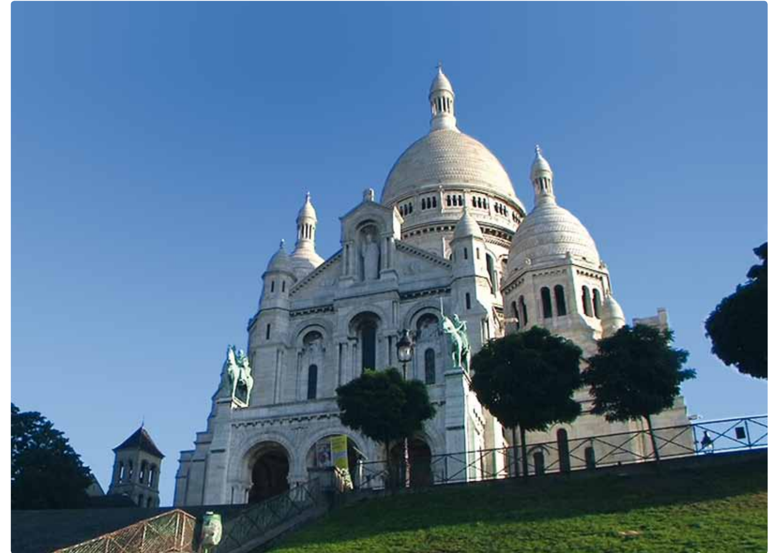
Au cours de la guerre de 1870, deux fervents chrétiens font le serment d'édifier une basilique consacrée au Sacré Cœur de Jésus au sommet de la butte Montmartre. En 1873 est adoptée une loi déclarant d'utilité publique la construction du Sacré-Cœur. 3 500 000 souscripteurs se manifestent et les travaux peuvent commencer trois ans plus tard. Quatre-vingt-trois puits sont forés à trente-six mètres de profondeur dans le gruyère de la butte, renforcés par des arcs de soutènement et un remplissage de maçonnerie. La basilique du Sacré-Cœur, un pastiche romano-byzantin, deuxième monument après la tour Eiffel qui domine Paris, produit une meilleure impression de loin que de près. Le campanile ne sera achevé qu'en 1912, et l'église consacrée après la guerre de 1914-1918.
