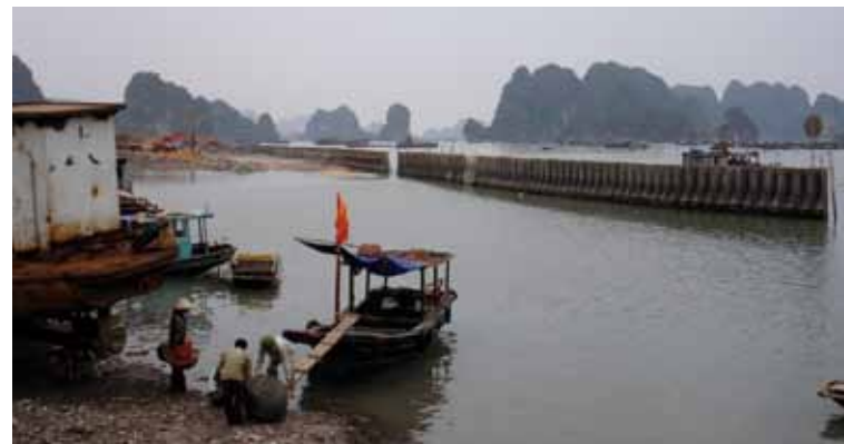
Une route en construction dans la baie !
